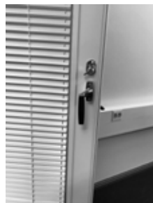
Ovi on varustettu tuu-lijarrulla ja jarrulaite lukkiutuu kääntämäl-lä painike ala-asen-toon
