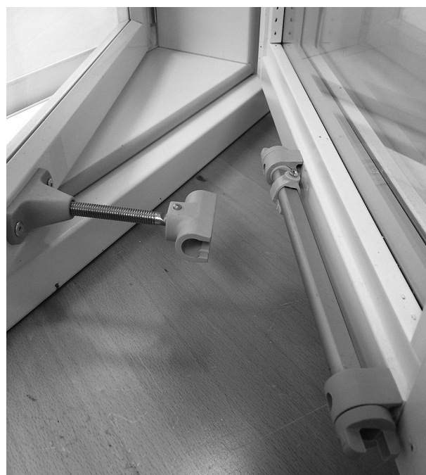
Liukukiskon lukitusvipu vaaka-asennossa (vapautettuna).
