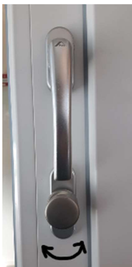
kuva, Parvekeoven painike ja vääntönuppi
