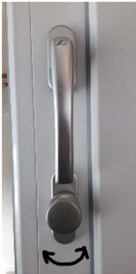
kuva, Terassioven painike ja vääntönuppi
